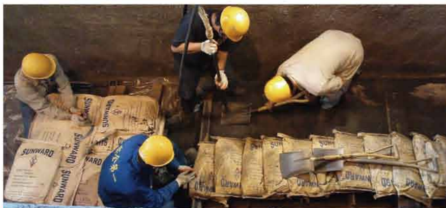
● 搗固材施工 Ramming.
