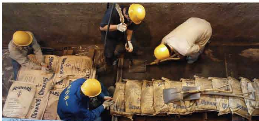
● 搗固材施工 Ramming.
